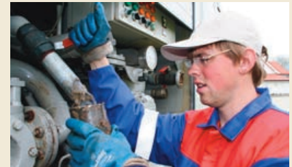
Ole Andreas Endresen kontrollerer septikvatnet.
