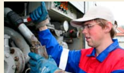
Ole Andreas Endresen kontrollerer septikvatnet.
