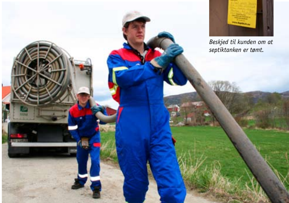
Avvatningsoperatørane Svein Malvin Marås (nærast) og Ole Andreas Endresen i ferd med å gjera klart for slamtømming. Renovatøren har rett til å plassera naudsynt utstyr på eigedommen, men pliktar å utføra tømminga med minst mogeleg støy og søl og å fjerna evt. søl.
