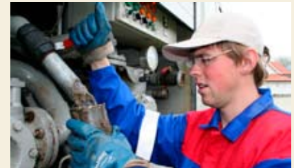
Ole Andreas Endresen kontrollerer septikvatnet.
