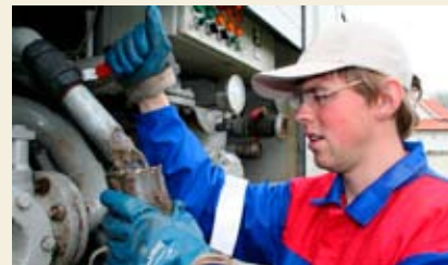
Ole Andreas Endresen kontrollerer septikvatnet.
