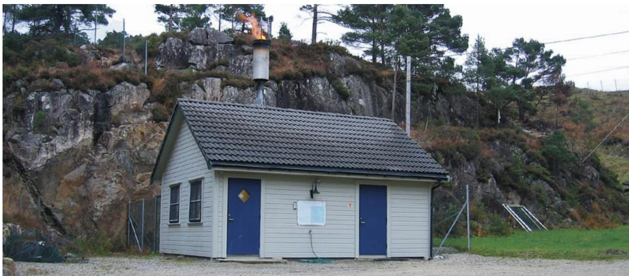
Gass vert sogen ut av fyllinga og brent i fakkel. Dermed vert metan-gassen omforma til den mindre skadelege gassen karbondioksyd.
