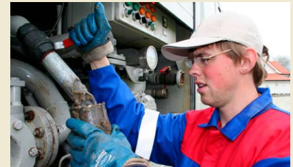
Ole Andreas Endresen kontrollerer septikvatnet.
