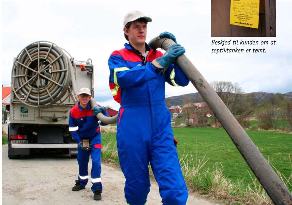
Avvatningsoperatørane Svein Malvin Marås (nærast) og Ole Andreas Endresen i ferd med å gjera klart for slamtømming. Renovatøren har rett til å plassera naudsynt utstyr på eigdommen, men pliktar å utføra tømninga med minst mogeleg støy og søl og å fjerna evt. søl.
