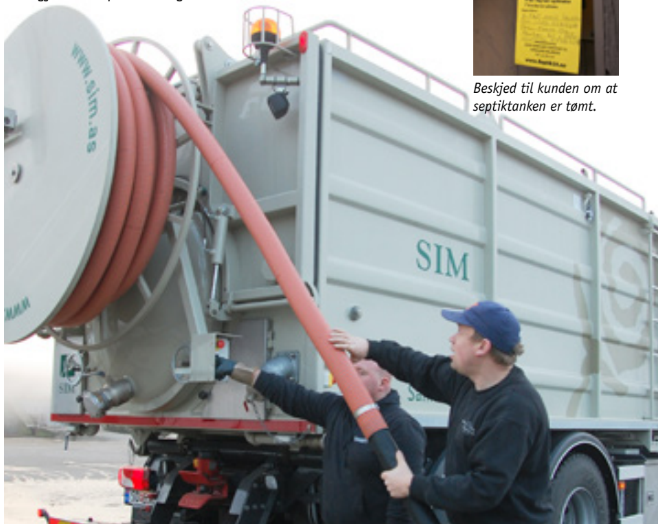
Avvatningsoperatørane Åge Raunholm (t.h) og Odd Gunnar Hustveit i ferd med å gjera klart for slamtømning. Renovatøren har rett til å plassera naudsynt utstyr på eigedommen, men pliktar å utføra tømninga med minst mogeleg støy og søl og å fjerna evt. søl.
