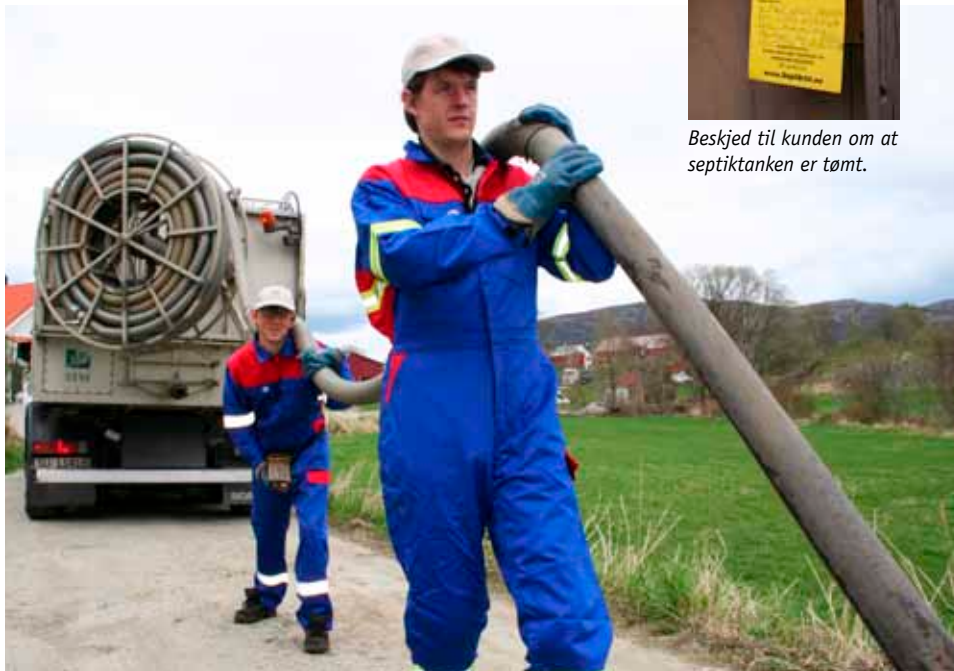
Avvatningsoperatørane Svein Malvin Marås (nærast) og Ole Andreas Endresen i ferd med å gjera klart for slamtømming. Renovatøren har rett til å plassera naudsynt utstyr på eigedommen, men pliktar å utføra tømninga med minst mogeleg støy og søl og å fjerna evt. søl.
