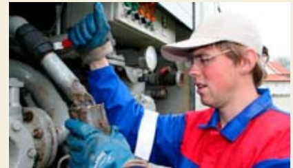
Ole Andreas Endresen kontrollerer septikvatnet.
